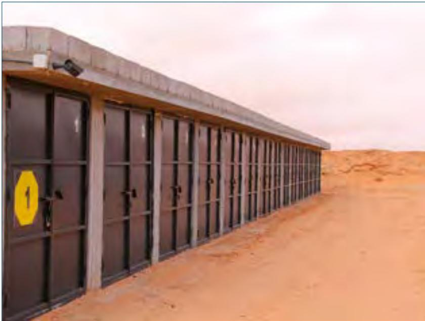
**d) Constructions aux parois épaisses.** Ces constructions sont faites de murs en maçonnerie d'une épaisseur minimale de 680 mm ou de murs de béton d'une épaisseur minimale de 450 mm et recouvertes d'un toit en béton armé d'une épaisseur minimale de 150 mm.<sup>133)</sup> En règle générale, compte tenu de l'épaisseur des murs, il n'est pas utile d'installer une traverse réceptrice.
