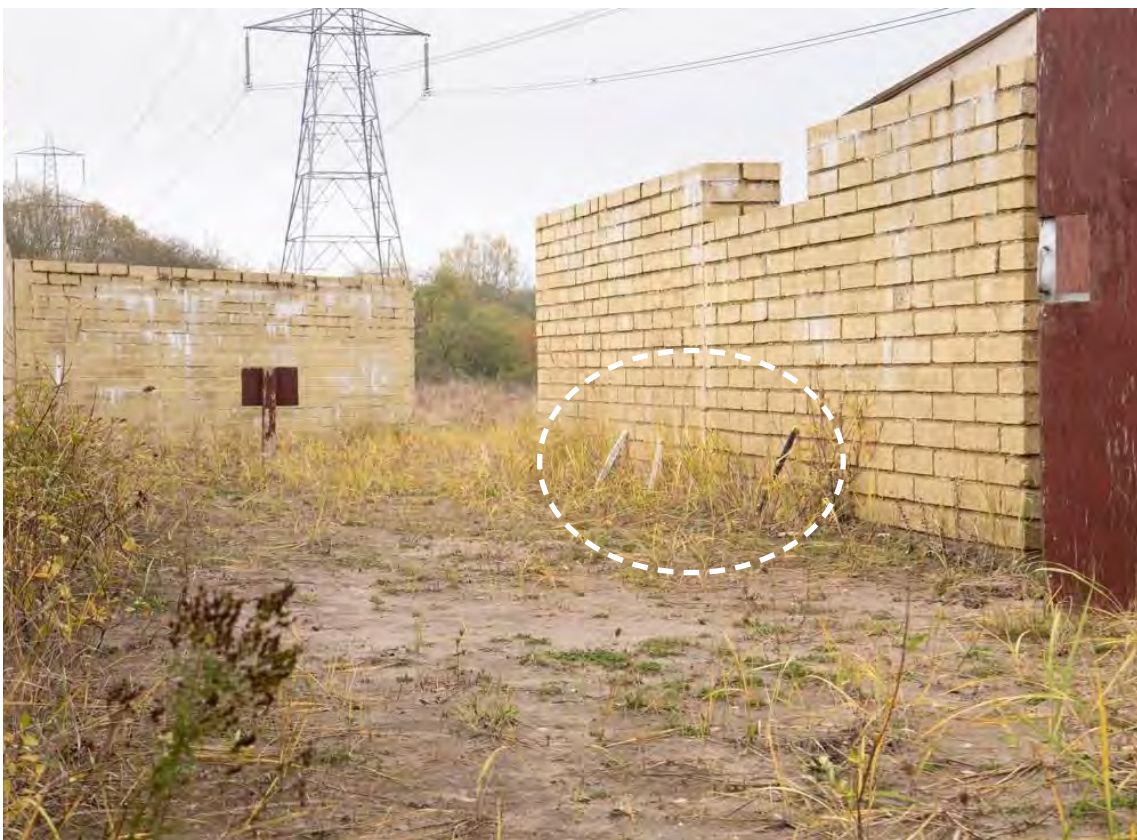
Imagen 50. Interruptores de AEI desechados (placas de presión) apoyados contra una pared.
