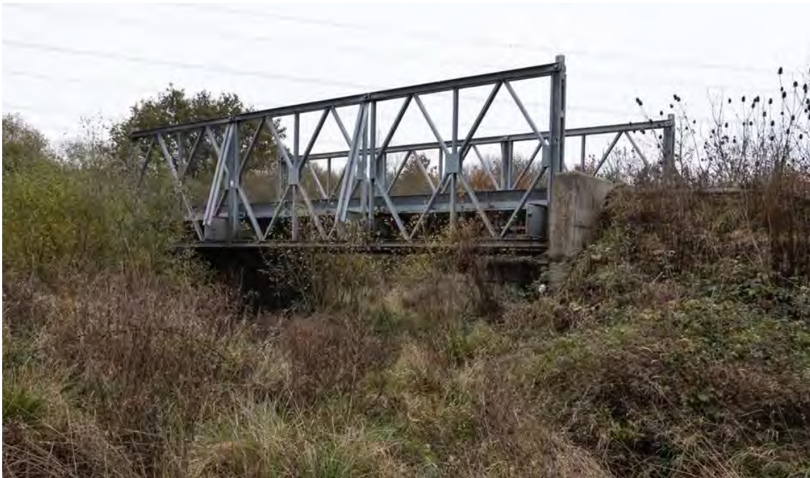
Imagen 24. Un puente es propicio para la colocación de AEI.
