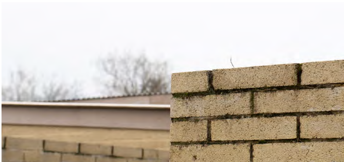
Imagen 55. Componente de AEI difícil de detectar - posible antena de artefactos explosivos improvisados controlados por radio (RCIED)
