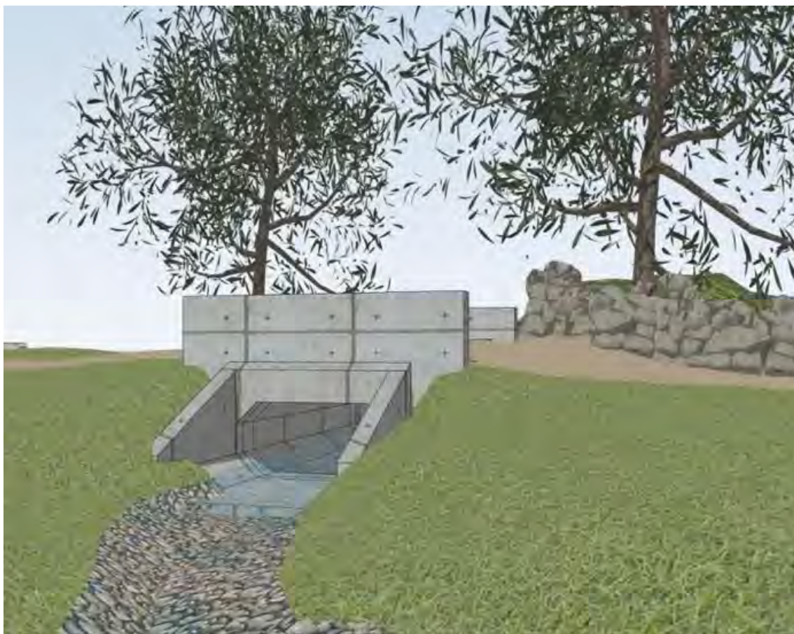
Imagen 23. Los pasos de agua son propicios para la colocación de AEI
