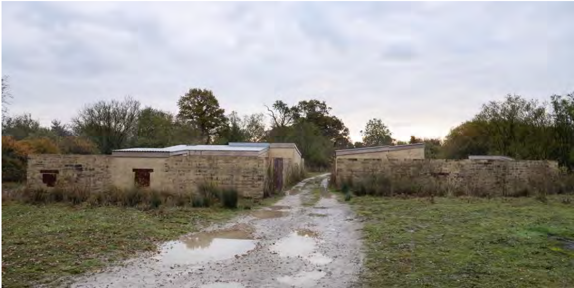
Imagen 11. Vía canalizada entre una serie de muros
