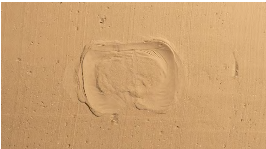
Imagen 38. Aplanamiento en condiciones controladas.
