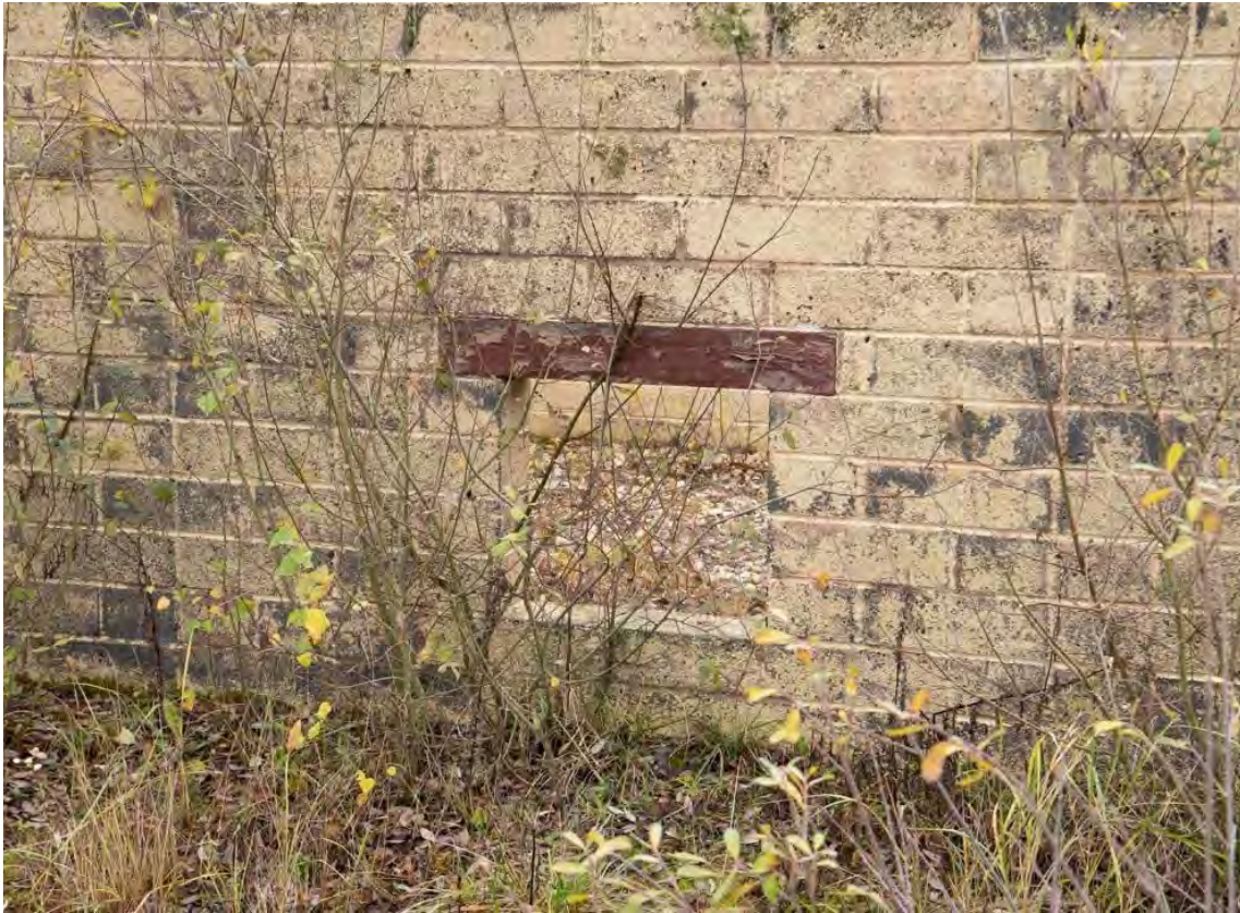
Imagen 13. Punto de entrada que ha quedado cubierto.
