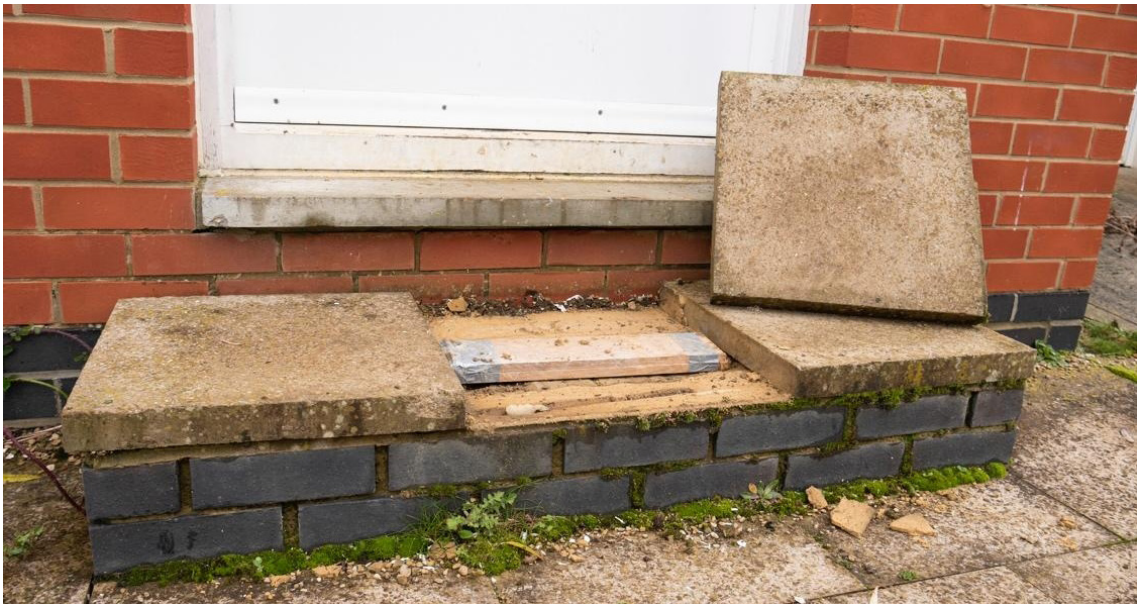
تصویر 70. وجود سطح سخت به این معنا نیست که همیشه از VOIED ها ایمن هستید.
