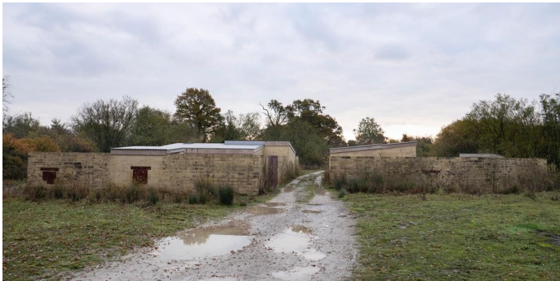
تصویر 11. یک مسیر دارای کانال بین چندین ساختمان
